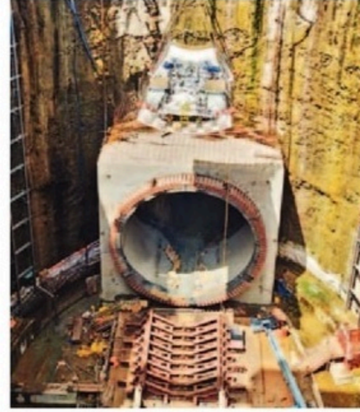
बुलेट ट्रेन मार्गातील बोगद्याच्या निर्मितीसाठी विक्रोळी येथे टनेल बोरिंग मशीन शाफ्टमध्ये खाली उतरविण्यात आले.
